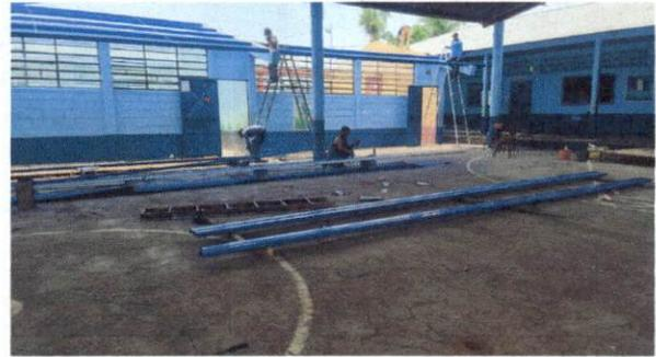
Foto 4: Cambio de techo y sustitución de estructura de soporte
